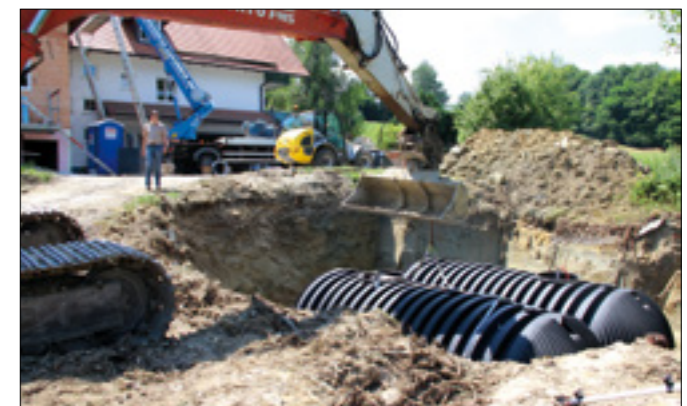
GRAF Carat XXL Klärbehälter mit einem maximalen Fassungsvermögen von jeweils 26.000 l.
