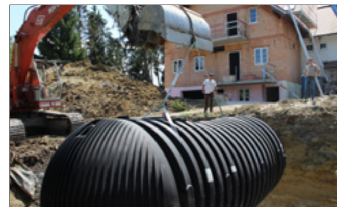
Nur mit einem Löffelbagger wurden die 26.000 l fassenden Klärbehälter GRAF Carat XXL eingebracht.
