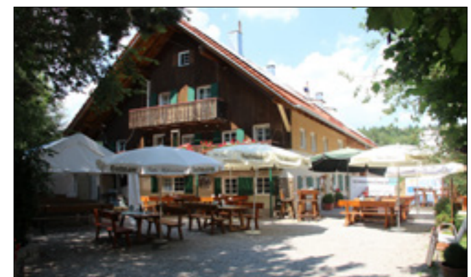
Das Wirtshaus „Beim Füchsle“ wurde um einen Anbau erweitert, um dem großen Gästezuspruch gerecht zu werden.
