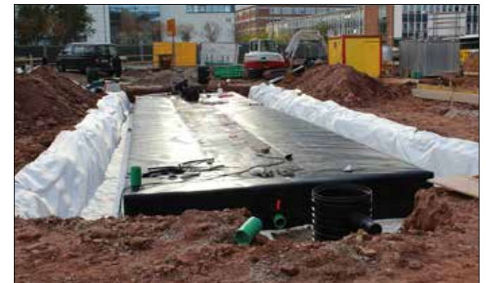
138 EcoBloc Inspect Module wurden innerhalb eines Tages vor Ort zu einem einlagigen (0,66 m Höhe) Blockverbund von 18,4 x 4,8 m montiert.
