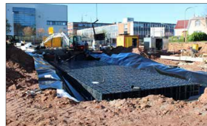
Die Rigolensole des Regenrückhaltesystems liegt etwa 1,60 m unter der Bodenplatte der Tiefgarage.
