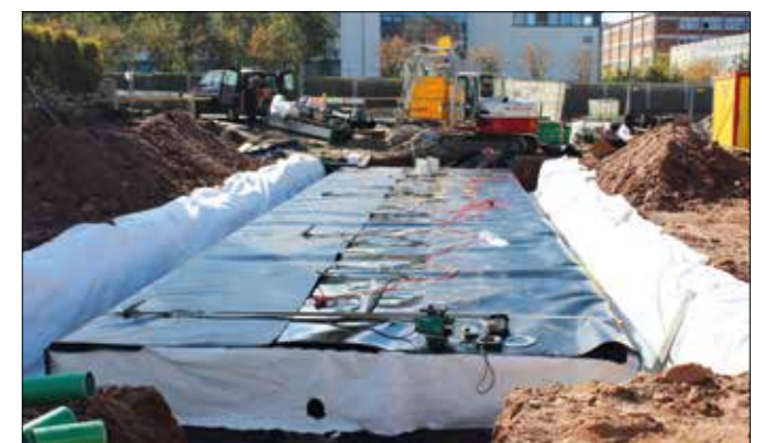
Der dreilagige Aufbau verhindert einen unkontrollierten Wasseraustritt aus den Modulen.
