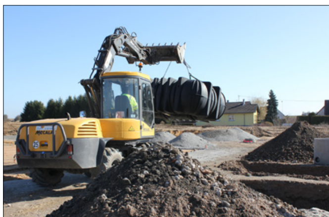
Le faible poids des cuves a permis une installation sans avoir besoin de recourir à une grue.
