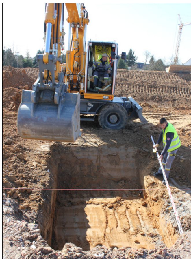
Les cuves extra-plates Platine ont été étudiées pour permettre une installation rapide et peu onéreuse grâce à une profondeur d'enfouissement réduite (80% d'excavation en moins par rapport à une cuve cylindrique).
