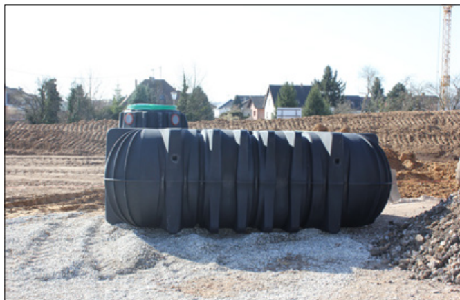
Les cuves ont été équipées pour permettre la rétention et la réutilisation des eaux pluviales récoltées.
