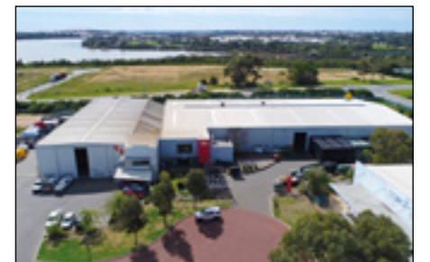
Perth (Australia) centro de producción y almacenamiento
