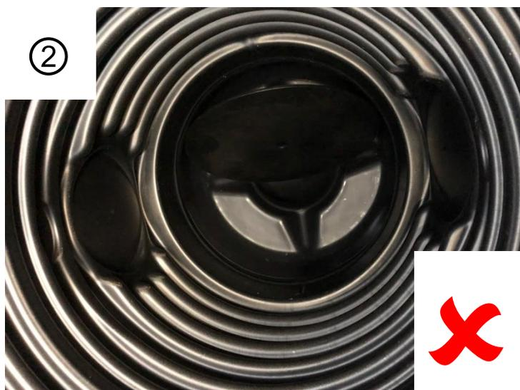
Nach Beseitigung der Verstopfung und/oder Herausnahme der Blende muss sichergestellt werden, dass die Blende wieder waagrecht und eben in den Wirbeldrosselschachtkörper eingelegt ist.
