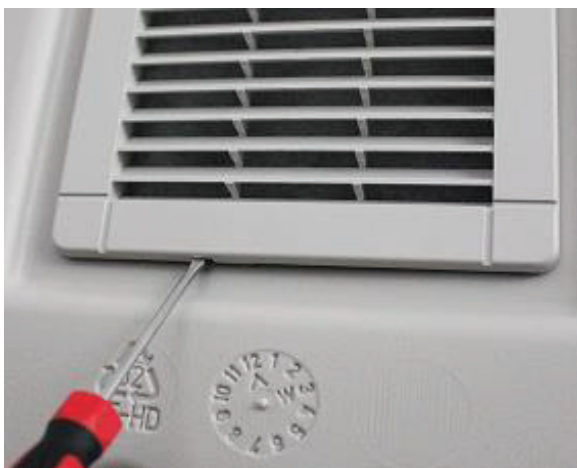
Imagen 11: Rejilla de ventilación abierta 15 x 15 cm
