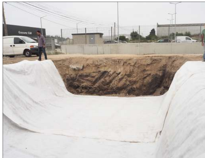
Colocação da manta de geotêxtil
