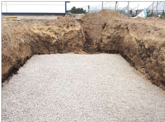
Colocação e nivelamento da base de la gravilha
