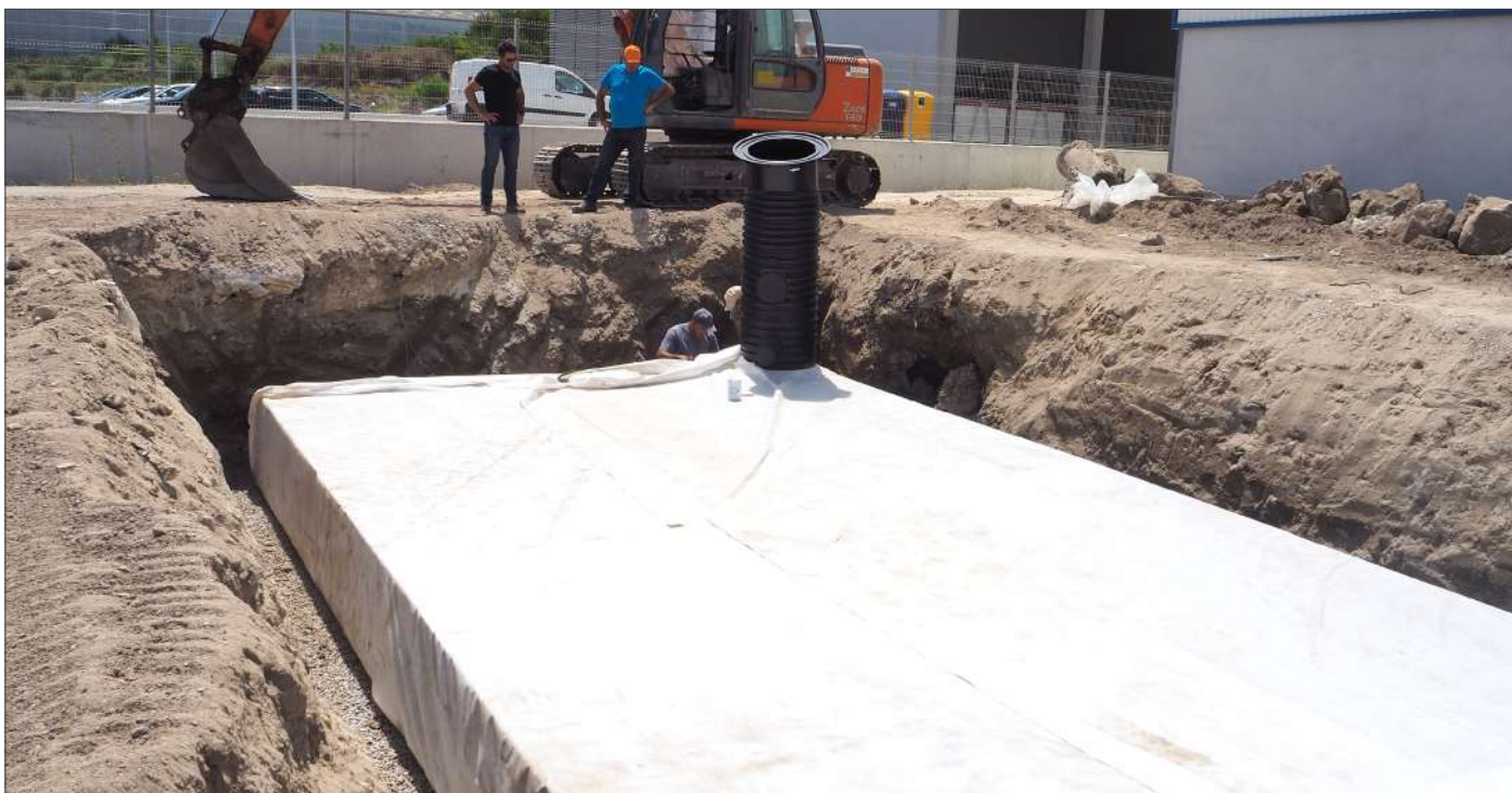
Envolver a estrutura com geotêxtil
