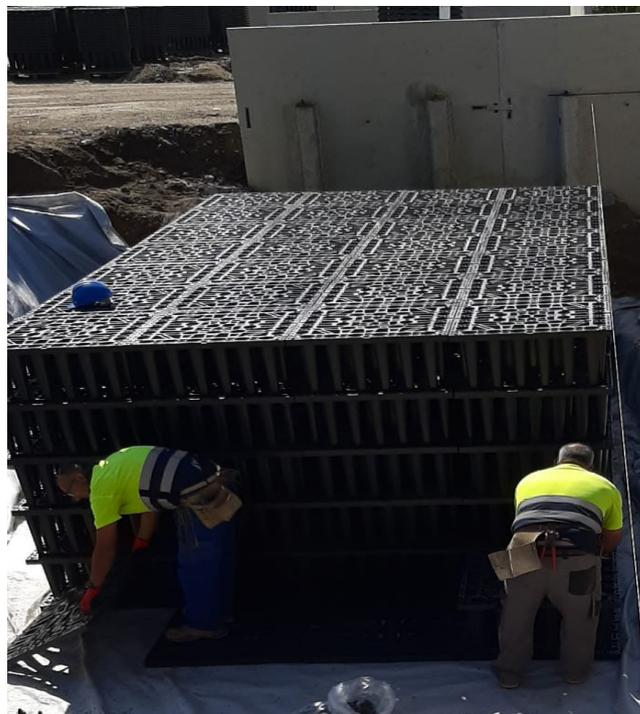
La **elevada capacidad de almacenaje de cada estructura** hará posible que **no quede agua retenida en la superficie durante los episodios de lluvia**, contribuyendo a su vez a la recarga de las masas de agua del subsuelo a medida que se produce la infiltración en el terreno, y reduciendo el exceso de caudal en el sistema de alcantarillado.
