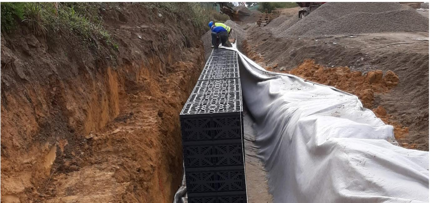
**El sistema Eco Bloc Maxx** resulta idóneo para esta aplicación, ya que permite el tránsito de vehículos de hasta 40T en las zonas donde se encuentran instalados los depósitos.
