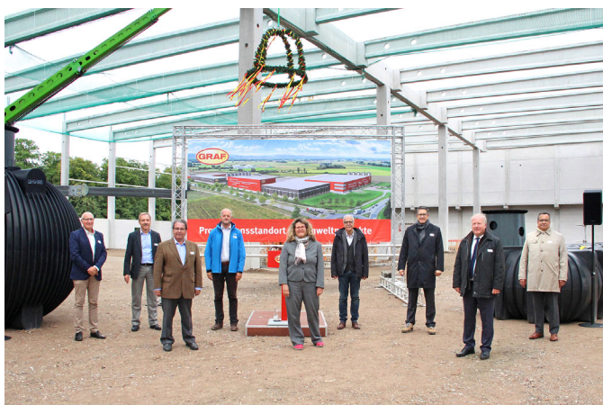
GRAF_PR_Richtfest_Werk-Neuried_01.jpg Inauguration du chantier de construction du site de Neuried. La mise en service est prévue au troisième trimestre 2021.
