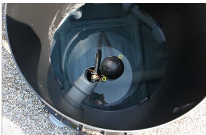
Les cuves de rétention GRAF sont équipées d'un régulateur de débit avec flotteur et trop-plein d'urgence.
