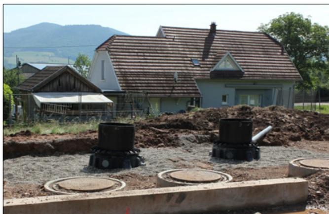
Les sorties de certaines cuves ont été inversées afin de permettre une installation en vis à vis et ainsi faciliter la pose.
