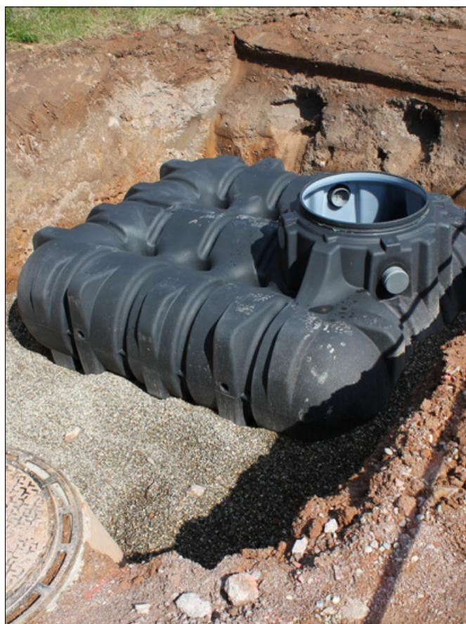
Les cuves extra-plates Platine ont été étudiées pour permettre une installation rapide et peu onéreuse grâce à une profondeur d'enfouissement réduite.
